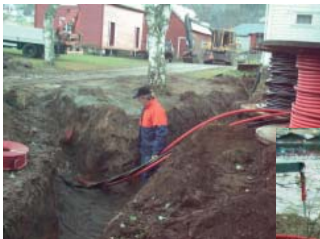
Magnar Moene legg fiberrøyr og høgspenkabel i Moe på Hafslo Foto: Hallgeir Hatlevoll
