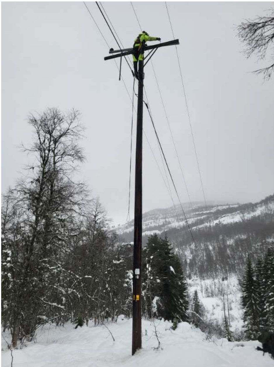
Arbeid i mast
