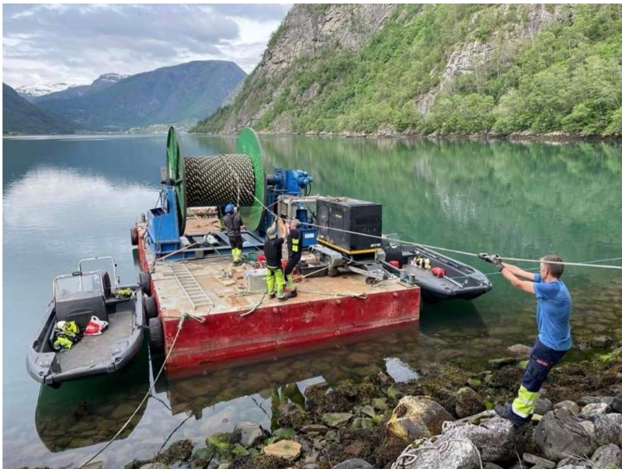
Legging av sjøkabel
