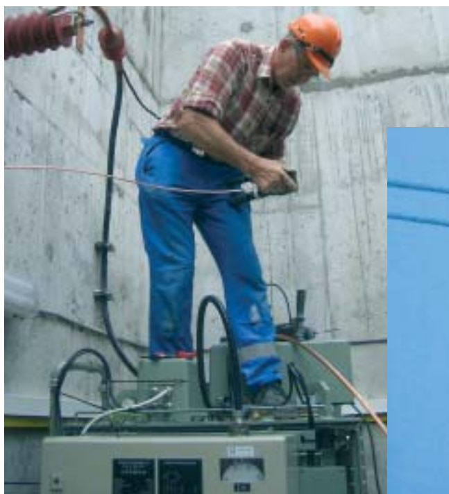
Montering av spole i Leirdøla Foto: Hallgeir Hatlevoll
