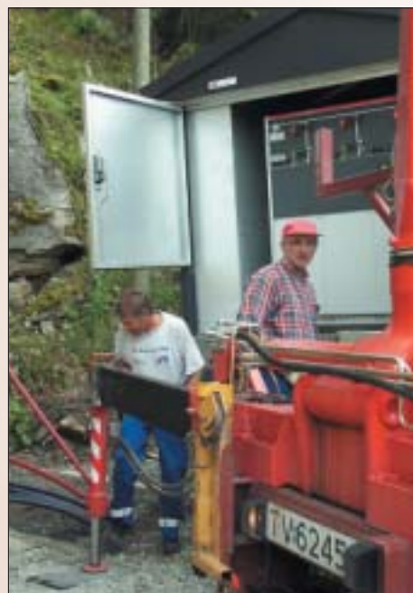
Montering av ny nettstasjon i Raumsberget. Foto: Hallgeir Hatlevoll.
