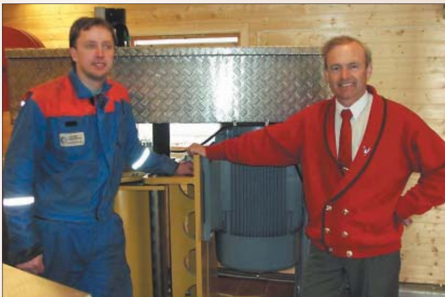
Installasjon av Marifjøra Minikraftverk. Foto Hans Arvid Skagen.
